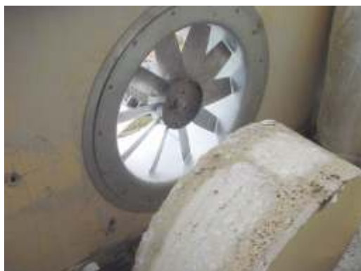
Abbildung: DBA-Mauereinbauventilator während der Bauarbeiten (Sanierungsbau)
